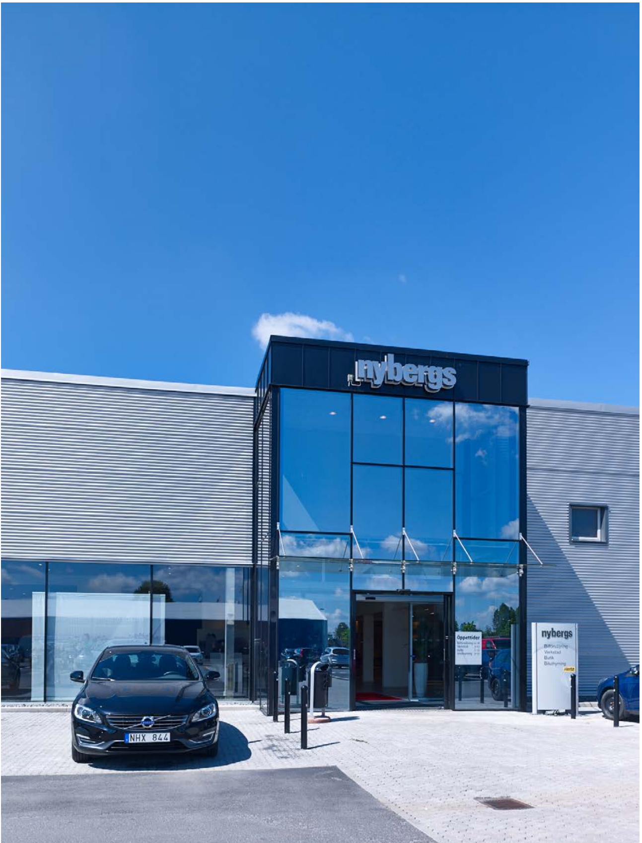
Nybergs Bil i Nässjö har 5050 SG i fasaden.
